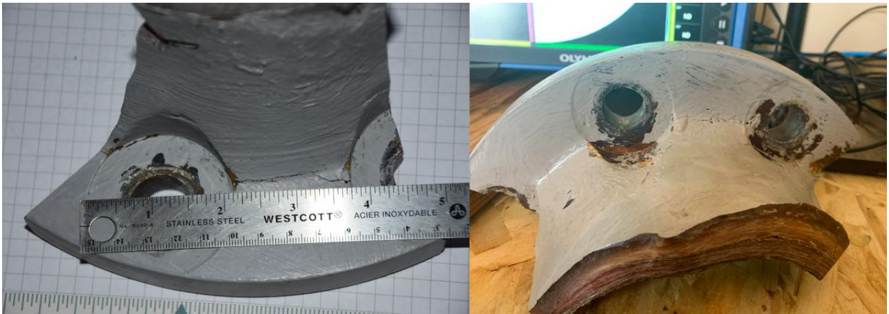
図2：FRP製フランジから切り出されたサンプルのボルト穴間の亀裂
